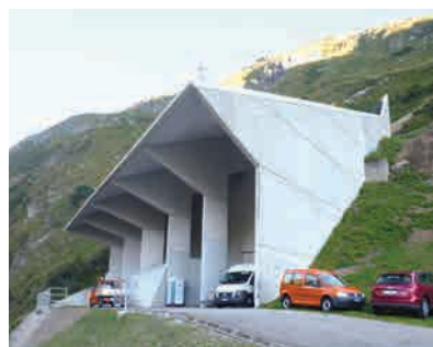
Eingang zum Lüftungsschacht
