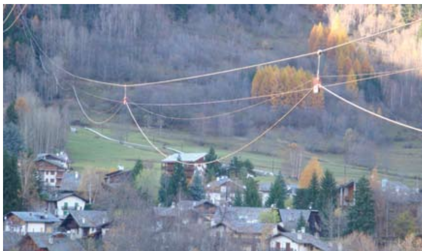
Mit «Ballerinas» wird das neue Tragseil am alten Seil aufgehängt.
