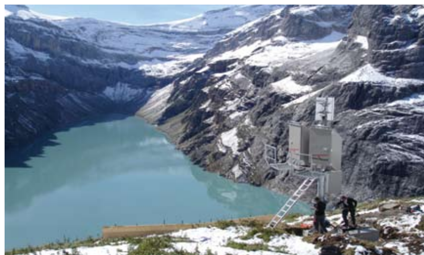
Lawinenwächter für das Linth-Limmern Kraftwerk
