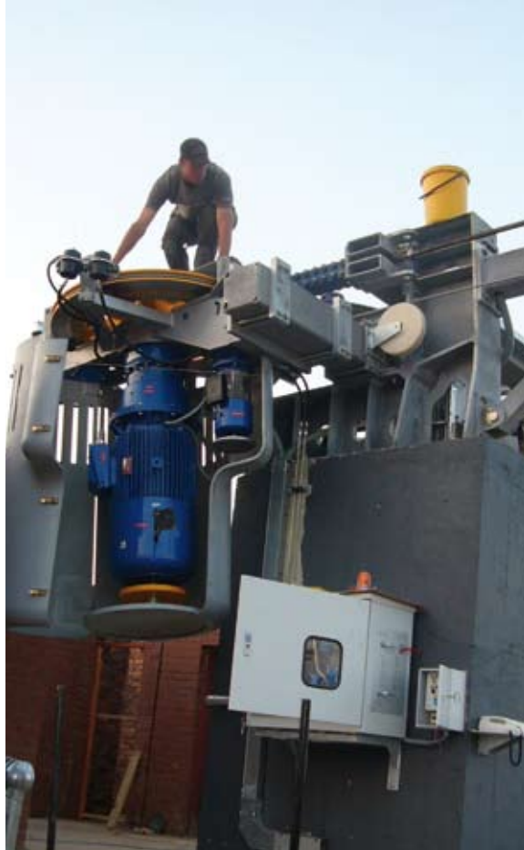
Der Antrieb wird montiert.
