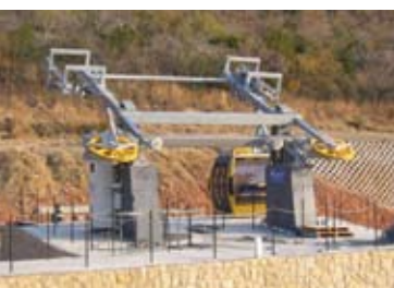
Neubau Pendelbahn Euphoria (Südafrika) mit Kabinen für 2 x 8 Personen
