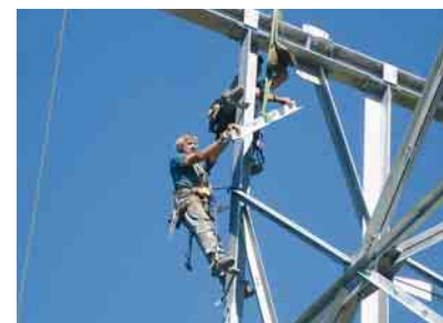
Montage der Stützen
