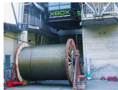
Seilzug für die Luftseilbahn Mulania-Grap Sogn Gion.
