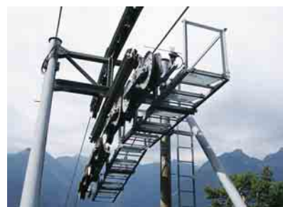
Neue Stützpodeste in Bodio
